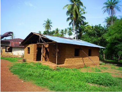
すでに村人たちでここまで建設されていた Mänge Bissan 診療所。しかし、お金がなく屋根半分で滞る
