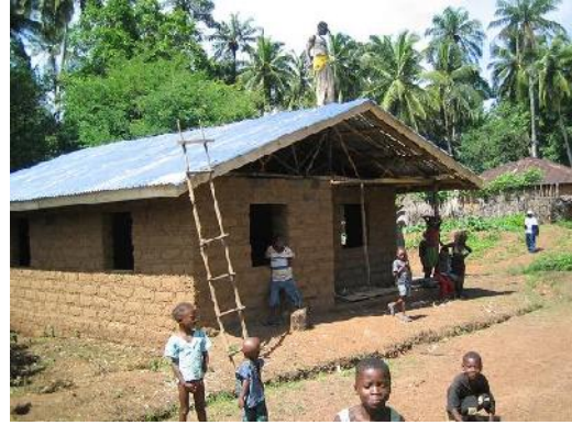
2008年7月19日、屋根が完成。
