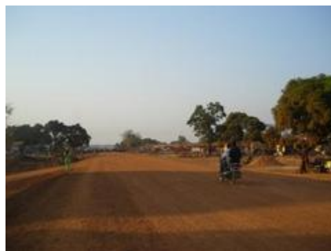
工事が始まった現在のカンビア中心街
